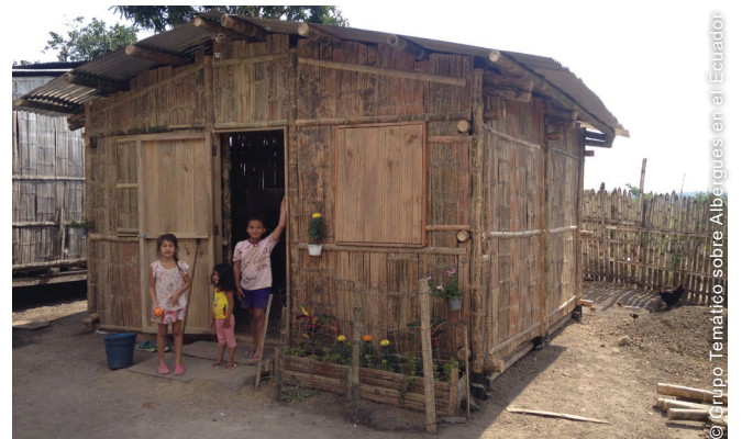
La mayoría de las opciones habitacionales apoyadas por la comunidad internacional se basaron en el uso de materiales de origen local, junto con techos de láminas de hierro galvanizado corrugado o recubrimiento en plástico.
