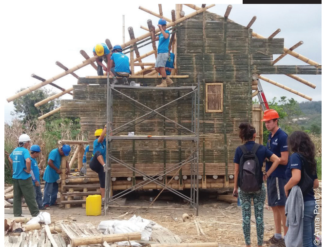
Las organizaciones humanitarias construyeron albergues transitorios con bambú del lugar, en muchos casos con la ayuda de voluntarios de ONG locales.
