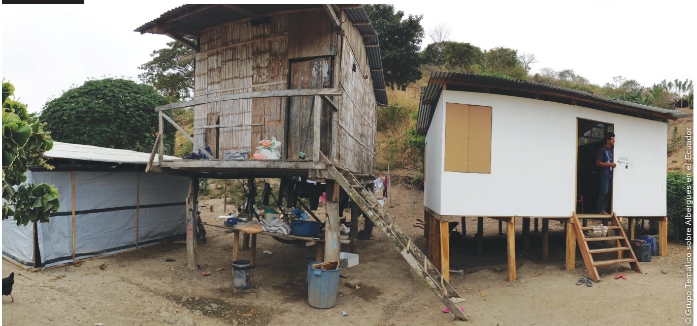
Los hogares afectados recibieron ya sea soluciones de albergue de emergencia, fabricadas principalmente con estructuras de bambú y lonas impermeables (izquierda) o albergues de transición, que durarían más tiempo (derecha). Sin embargo, al principio se temió que las soluciones consideradas más "permanentes" privaran a las personas de la asistencia del Gobierno.
