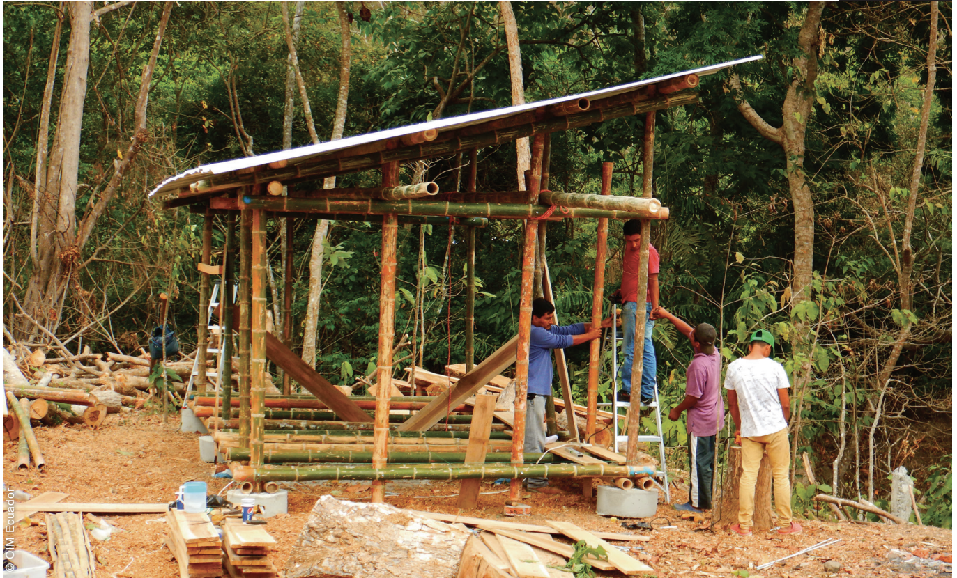
Pese a la resistencia inicial del Gobierno, muchos organismos propusieron soluciones de albergue temporales o transitorias basadas en el uso de materiales locales (como el bambú), que ofrecían condiciones de vida adecuadas para el intervalo entre la fase de emergencia y el proceso oficial de reconstrucción (planificado por el Gobierno).
